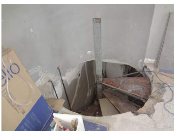
FOTO 81- Escada vista do 19º pav., apartamento 184 – Bloco A, vistoriado por este signatário.
