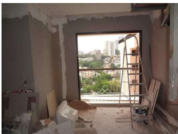
FOTO 69- Sala e ao fundo da Varanda, apartamento 184 – Bloco A, vistoriado por este signatário.
