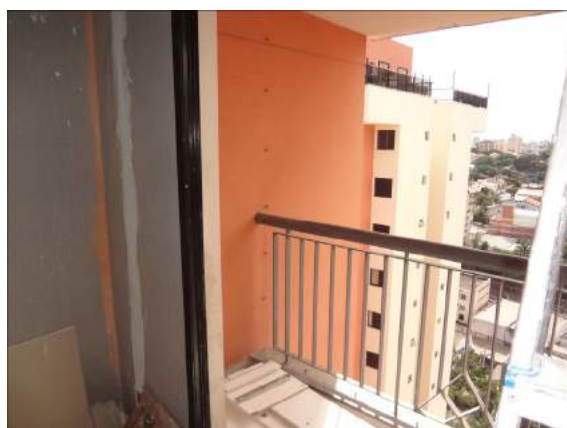
FOTO 78- Varanda, apartamento 184 – Bloco A, vistoriado por este signatário.
