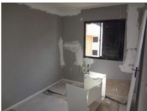
FOTO 75- Dormitório 1, apartamento 184 – Bloco A, vistoriado por este signatário.
