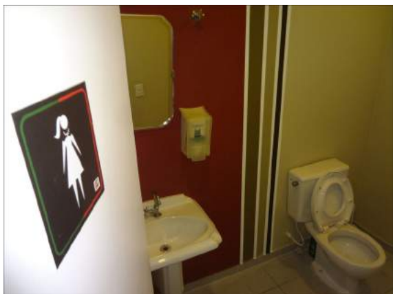
FOTO 24- Sanitário Feminino do Salão de Festas, Bloco A.
