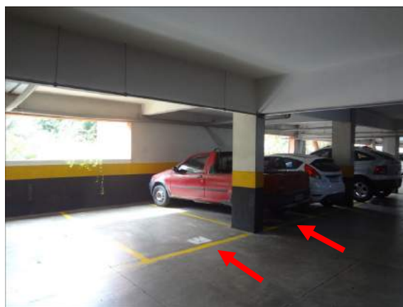
FOTO 92- 1ª e 2ª Vaga - nº 184 A, do apartamento 184 Bloco A, vistoriado por este signatário.
