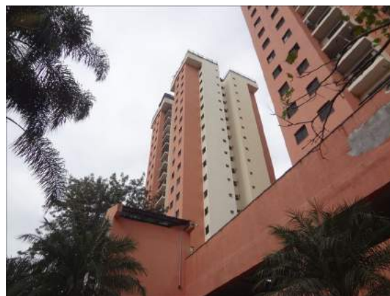
FOTO 8- Vista do Bloco C.
