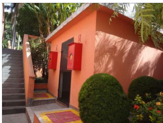
FOTO 47- Sala do Gerador.
