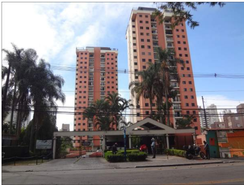
Vista da Portaria do Condomínio Riviera Italiana.
