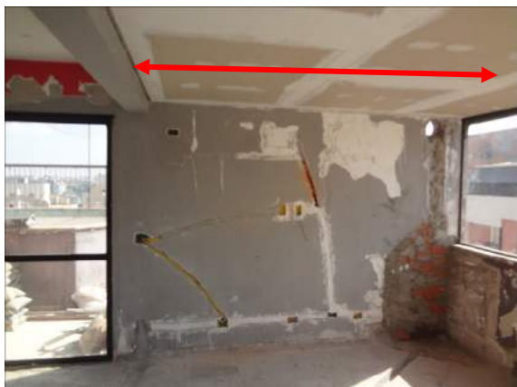
FOTO 83- Sala no 19º pav., apartamento 184 – Bloco A, vistoriado. Ampliação (linha vermelha = largura), idêntica ao apartamento 183 – Bloco C, penhorado .
