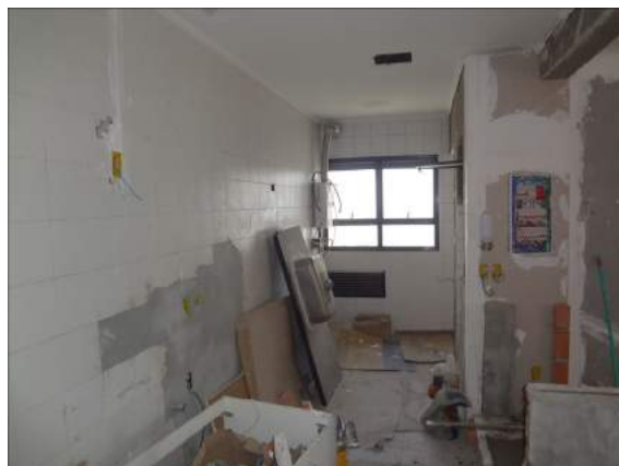
FOTO 66- Cozinha e ao fundo a Área de Serviço, apartamento 184 – Bloco A, vistoriado por este signatário.
