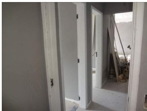
FOTO 74- Corredor, a esquerda temos o Dormitório 1 e 2, apartamento 184 – Bloco A, vistoriado por este signatário.
