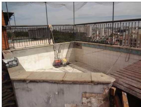
FOTO 90- Piscina no Terraço do 19º pav., apartamento 184 – Bloco A, vistoriado por este signatário.
