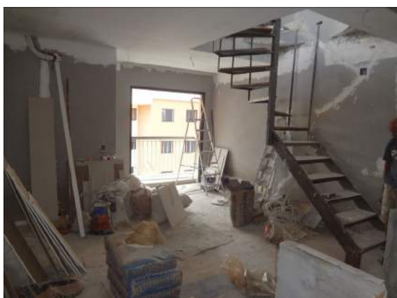
FOTO 77- Sala, Varanda e a escada para o 19º pav., apartamento 184 – Bloco A, vistoriado por este signatário.
