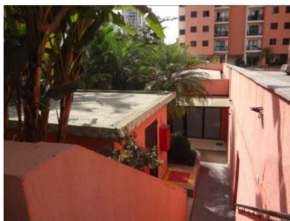
FOTO 37- Escada de acesso: Sala do Gerador a esquerda, Academia ao fundo e Salão de Jogos Infanto Juvenil a direita.
