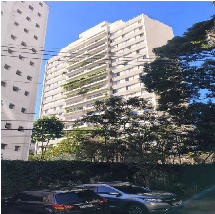
Vista da fachada do edifício
