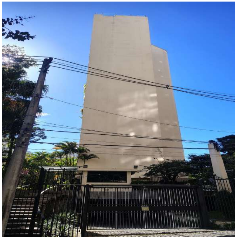
Vista da fachada lateral do edifício
