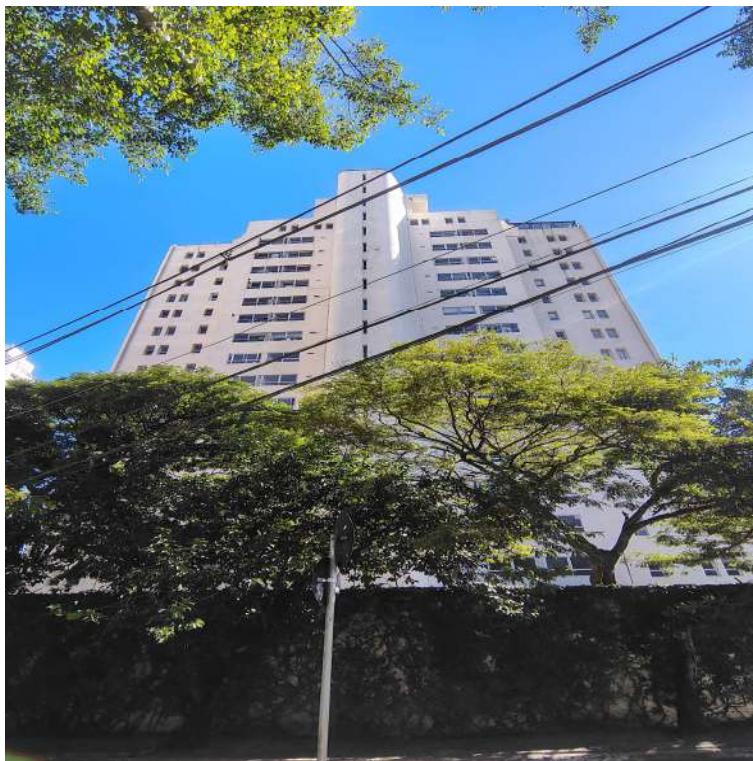
Vista da fachada do edifício
