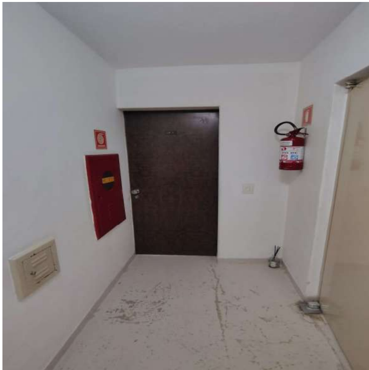
Vista do hall da área de serviço
