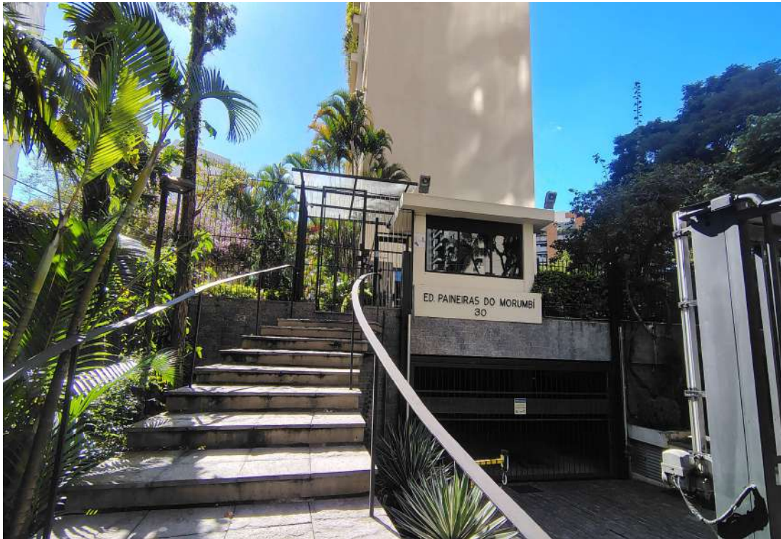
Acesso ao edifício
