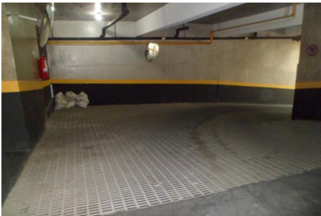
FOTO nº 34 Vista da rampa de acesso da área de estacionamento.
