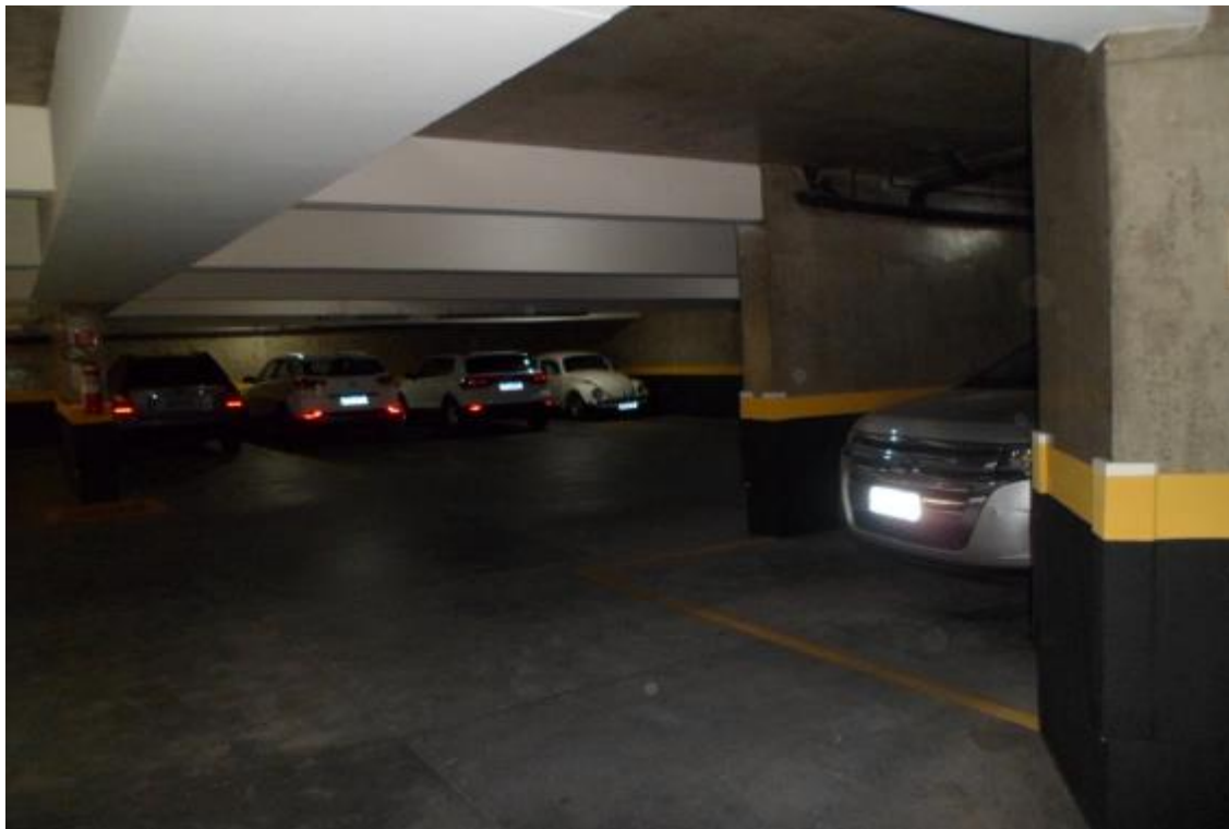
FOTO nº 35 Vista da área de estacionamento.
