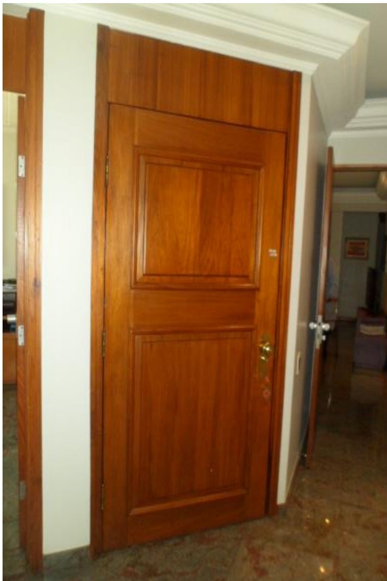
FOTO nº 06 Vista da porta de acesso do apartamento de nº 91, localizado no 9º andar.
