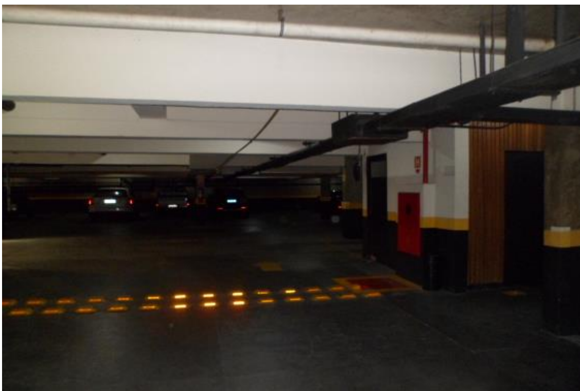
FOTO nº 36 Vista da área de estacionamento, tomada de outra posição.
