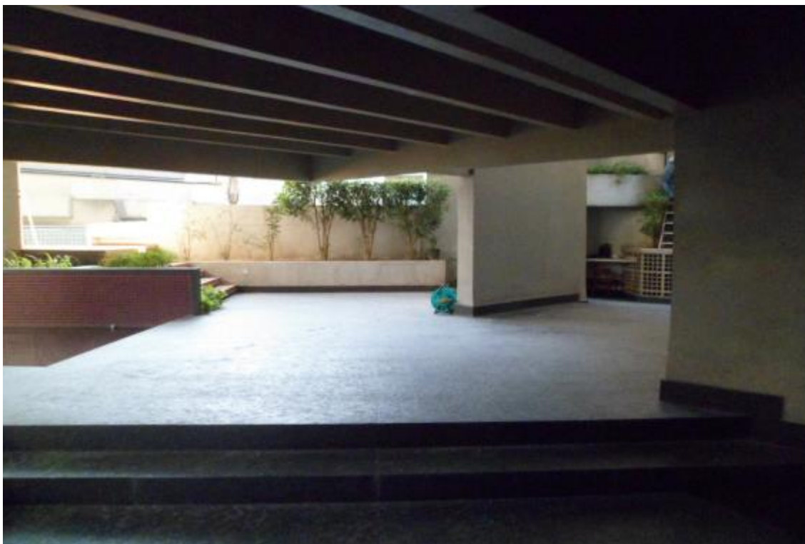
FOTO nº 01 Vista da área de acesso do edifício octógono, onde se localiza o apartamento de nº 91, no 9º andar.
